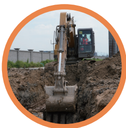
Fondation de bâtiments
