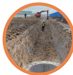
Creusement de tranchées
