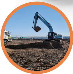
Nivellement de terrain
