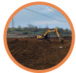
Nivellement de terrain agricoles
