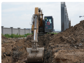
Fondation de bâtiments
