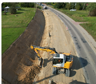
Construction de routes et d'autoroutes
