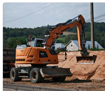
Construction de pentes et de talus
