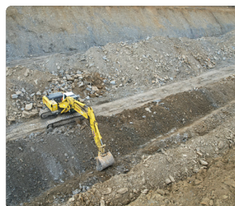
Excavation de tranchées
